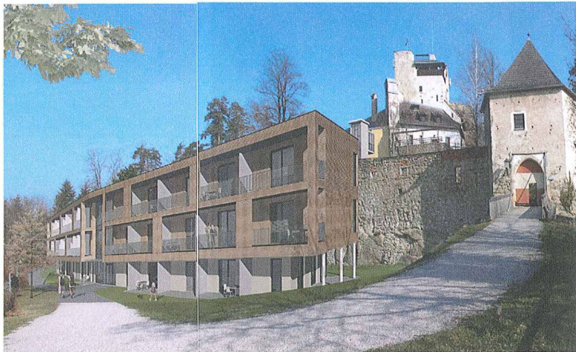
Um sechs Millionen Euro wird in Bad Kreuzen die Burg saniert und ein Jugendhotel errichtet.
